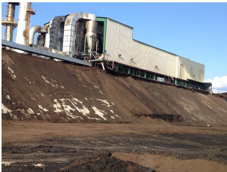
FOTO 12. SILO DE MATERIA PRIMA PARA LA TRANSFORMACIÓN EN ENERGÍA ELÉCTRICA MEDIANTE COMBUSTIÓN (EL TEJAR S.C.A.)
